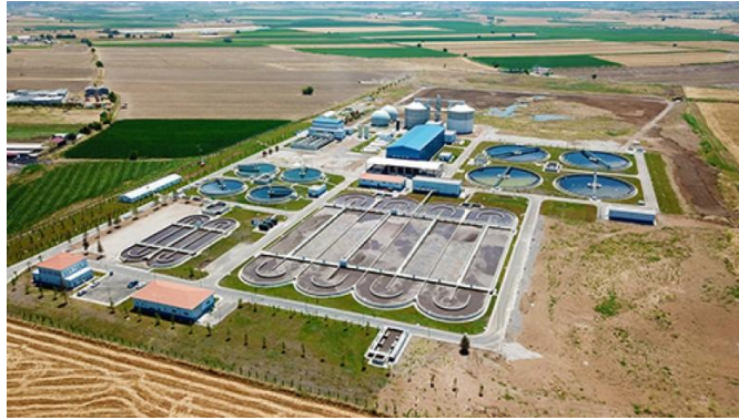
Atıksu Arıtma Kolektör Yapım İş
