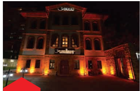
Yozgat Yatırım Destek Ofisi
