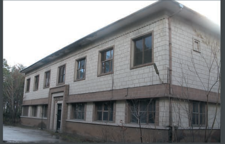
ORAN Kayseri Merkez Hizmet Binası Restorasyon Öncesi
