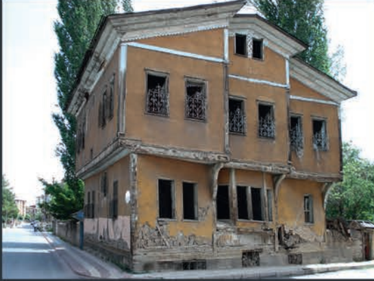
ORAN Sivas Yatırım Destek Ofisi Hizmet Binası Restorasyon Öncesi
