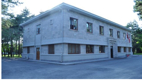
Resim 1. ORAN Merkez Hizmet Binası
